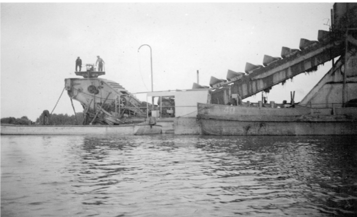
□ Een baggermolen in "De Breek" aan het werk. De foto is van 1941. Fotoarchief O.V.L.
